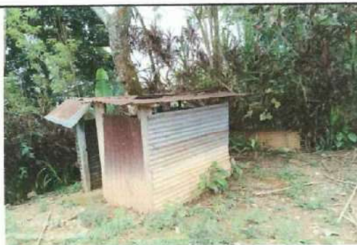
Foto 6: Reparacion y cambio de baño
