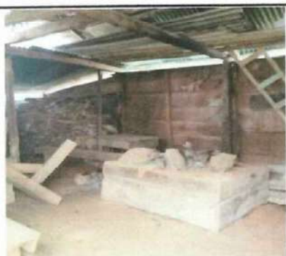
Foto 5: Entortado de cemento.
