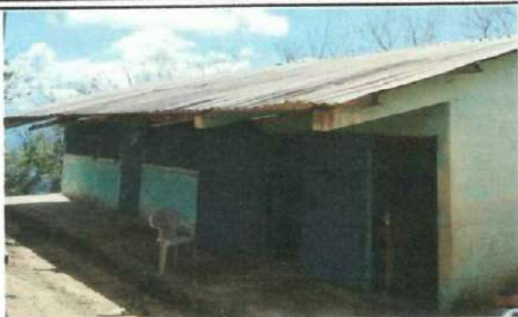
Foto1: Cambio de pintura aula 1, 2 y Direccion y pintada de balcones.
